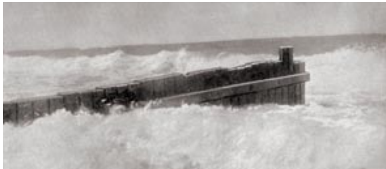
Bild 2: Buhne aus Schlackensteinen auf Eisenbetonpfählen, Sylt (aus [1])
