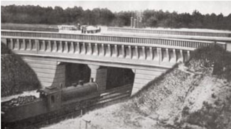
Bild 4: Brückenkanal des Großschifffahrtswegs Berlin–Stettin (aus [1])
