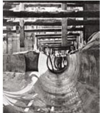
Bild 5: Kanalbau in München (600 t Eisenportlandzement) (aus [1])
