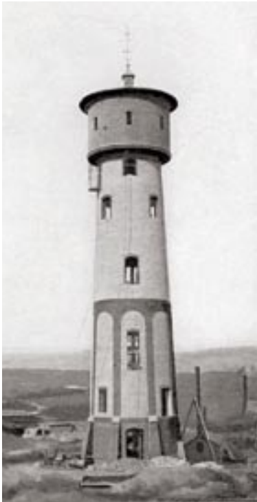
Bild 6: Wasserturm auf Sophienhütte Wetzlar – Bassin 105 m 3 fassend, aus Eisenbeton, Schaft aus Schlackensteinen (aus [1])
