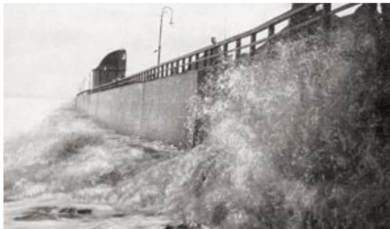
Bild 1: Ufermauer auf Sylt, Westerland (2.550 t Eisenportlandzement) (aus [1])
