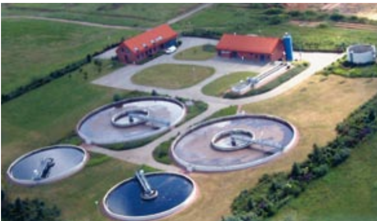
Bild 12: Kläranlage Coswig (Luftbild)
