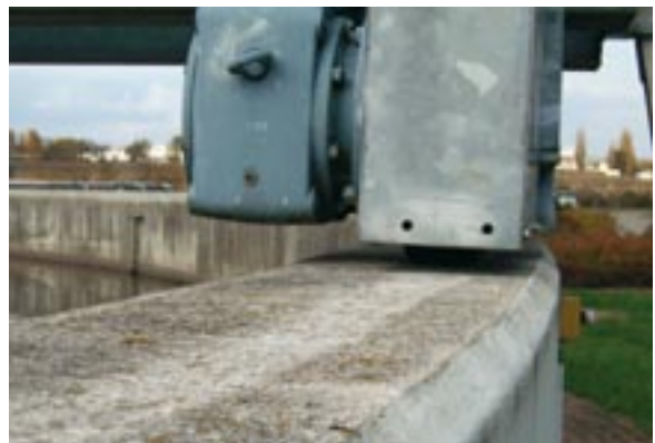
Bild 22: Laufrad und Belebungsbecken 2 (Coswig)
