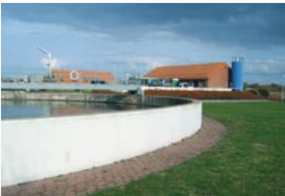
Bild 21: Bio-P-Becken mit Maschinenhaus im Hintergrund (Coswig)
