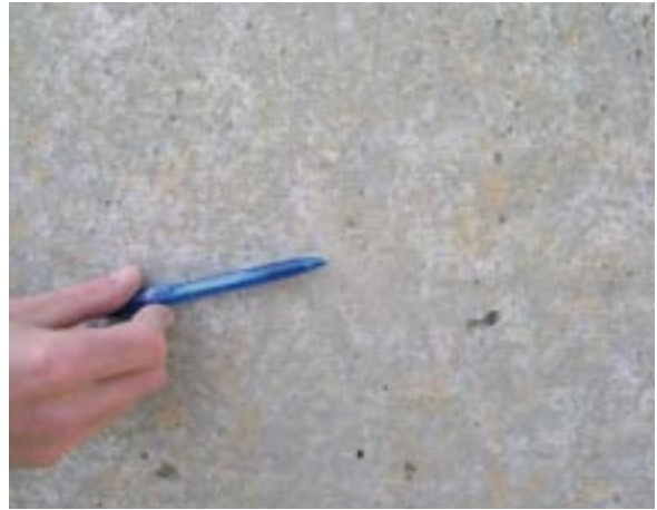
Bild 7: Innenansicht Nachklärbecken 2 nach Abbürsten der Oberfläche
