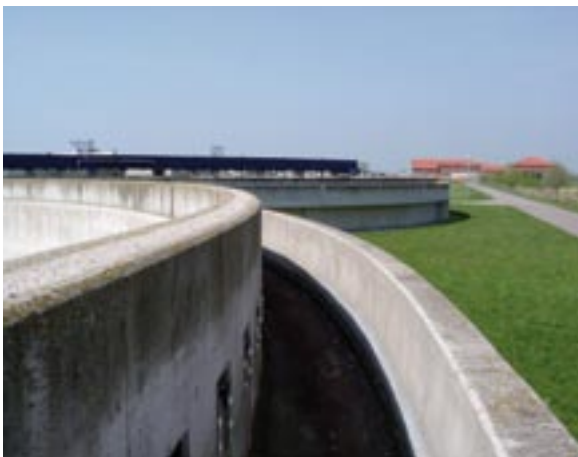
Bild 8: Räumlerlaufbahn und Gerinne von Nachklärbecken 2 (Wittenberg)
