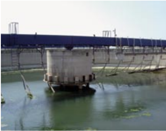
Bild 6: Innenansicht Nachklärbecken 2 (Wittenberg)
