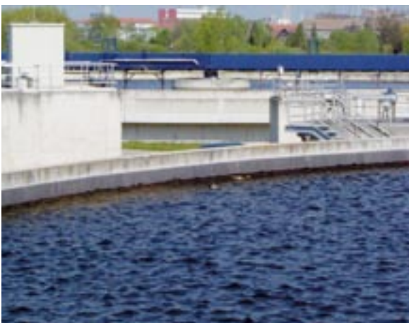
Bild 4: Blick über das Nachklärbecken 3 (Wittenberg)
