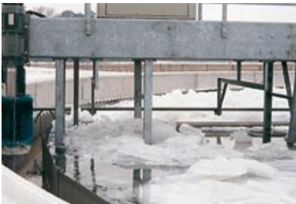
Bilder 15 und 16: Räumerbücke über Nachklärbecken 2 (Coswig) im Januar 1996
