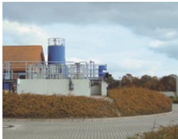
Bild 2: Ansicht der Kläranlage Coswig mit Sandfang
