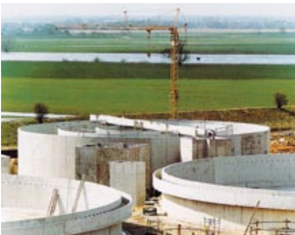
Bild 1: Kläranlage Wittenberg 1994, Nachklär- und Belüftungsbecken
