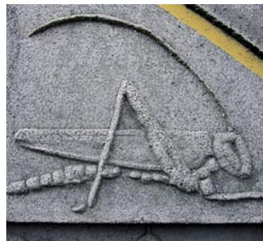
Bild 11 (1996) und Bild 12 (2005): Abdruck des Polystyrols auf der Betonoberfläche
