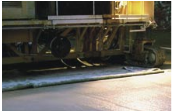
Bild 13: Oberflächenfertiger mit Kunststrasen zur Oberflächenstrukturierung
