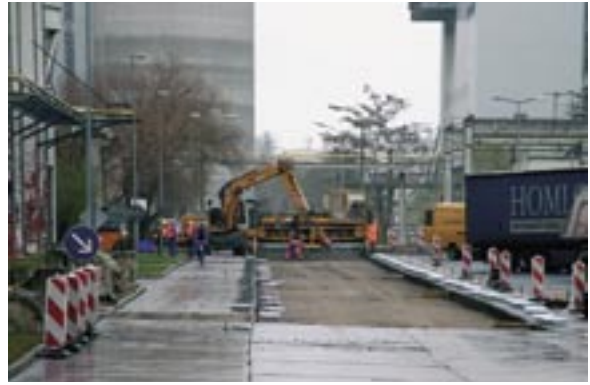
Bild 11: Einbau der Beobachtungsstrecke mit einem Gleitschalungsfertiger
