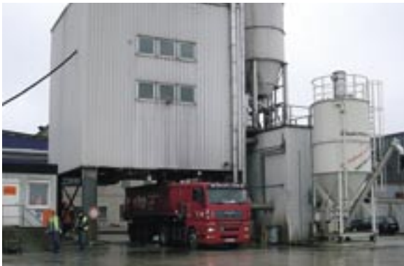
Bild 12: Betonmischanlage mit zwei Teller-Chargenmischern (Leistung bei steifer Konsistenz 1 m 3 pro Mischer)
