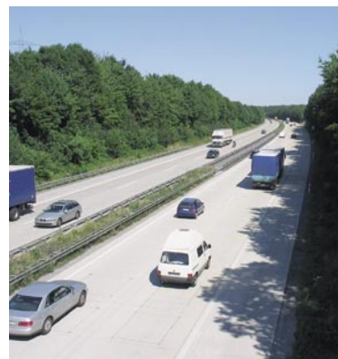
Bild 1: Die helle Fahrbahnoberfläche erhöht die Verkehrssicherheit.
