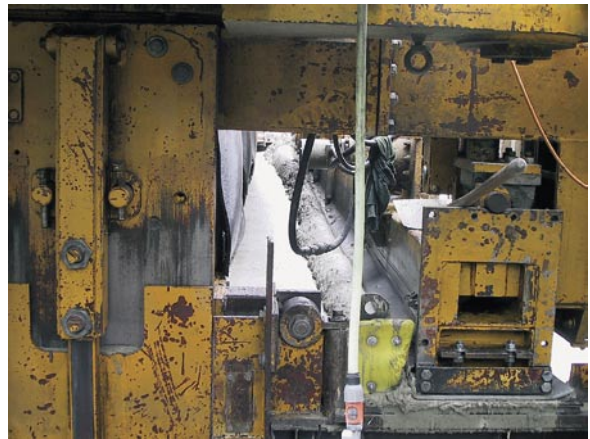
Bild 6: Bei optimaler Konsistenz und Einstellung des Fertigers schiebt der Querglätter eine gleichmäßige „Betonrolle“ vor sich her.
