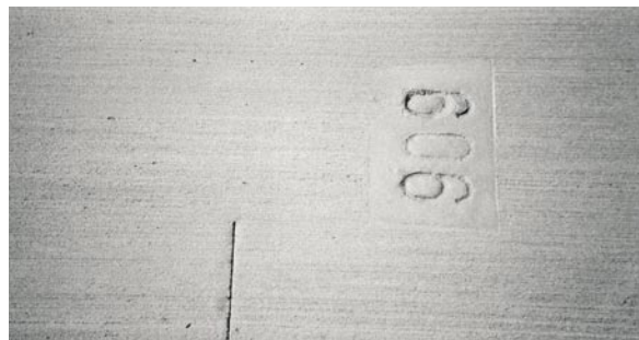
Bild 8: Fahrbahnoberfläche mit Jutetuchstruktur, Feldnummerierung und Kennzeichnung für den Fugenschnitt
