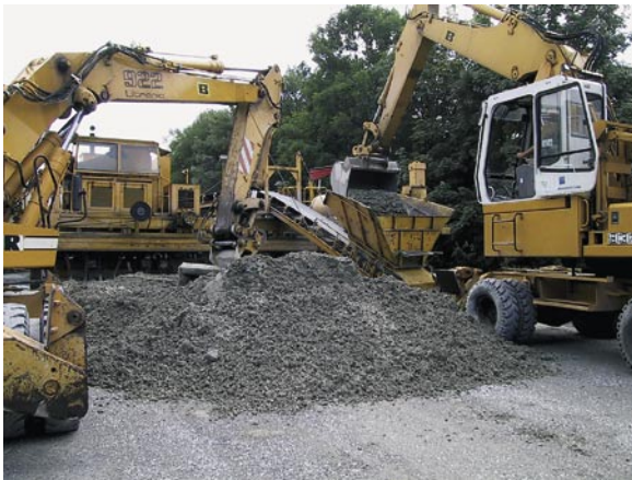
Bild 5: Zweischichtiger Einbau – der Unterbeton liegt vor dem Gleitschalungsfertiger, der Oberbeton wird in den Aufgabetrichter mit Förderband übergeben.
