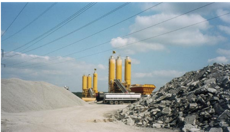
Bild 4: Aufbruchmaterial der alten Betonfahrbahn (rechts); aufbereitete Recyclingkörnung (links); Mischanlagen für Unter- und Oberbeton (Mitte)
