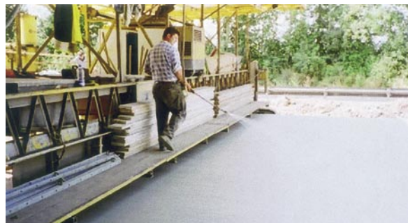
Bild 10: Aufsprühen eines pigmentierten Nachbehandlungsmittels auf die mattfeuchte Oberfläche
