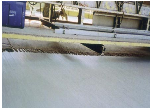
Bild 7: Texturierung der Fahrbahnoberfläche mit nachgeschlepptem Jutetuch
