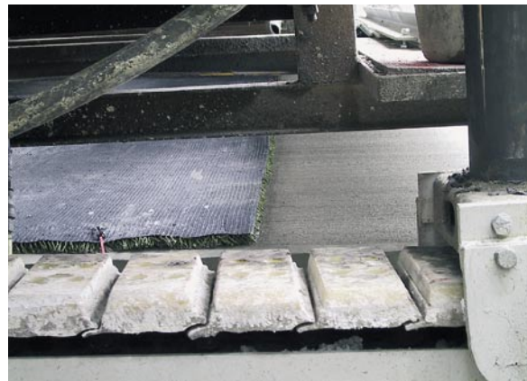
Bild 9: Texturierung der Betonfahrbahndecke in Teilbereichen durch Nachziehen eines Kunstrasenteppichs
