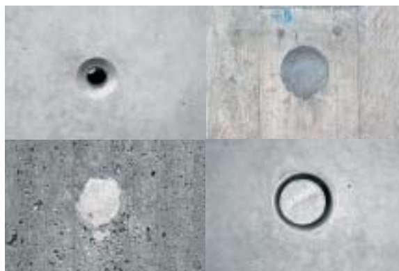
Bild 2: Verschluss der Ankerhülsen
