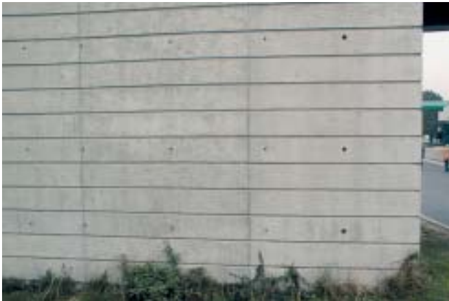
Bild 6: Horizontale Kehlen zur Vergleichmäßigung des Wasserabflusses
