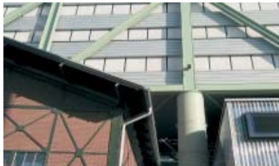
Bild 11: Unbeschichteter Pfeiler zwischen ehemaliger Elektrozentrale und Multifunktionshalle
