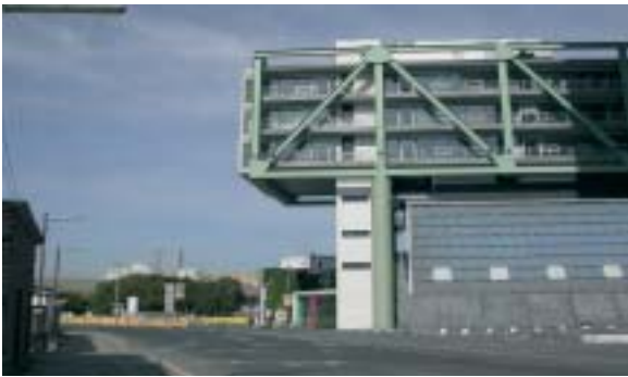
Bild 5: Eingangsbereich des Port Event Centers mit der Multifunktionshalle unter der auf den Betonpfeilern ruhenden Stahlkonstruktion
