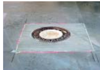
Bild 19: Ortbetonergänzung um die Schachtabdeckung
