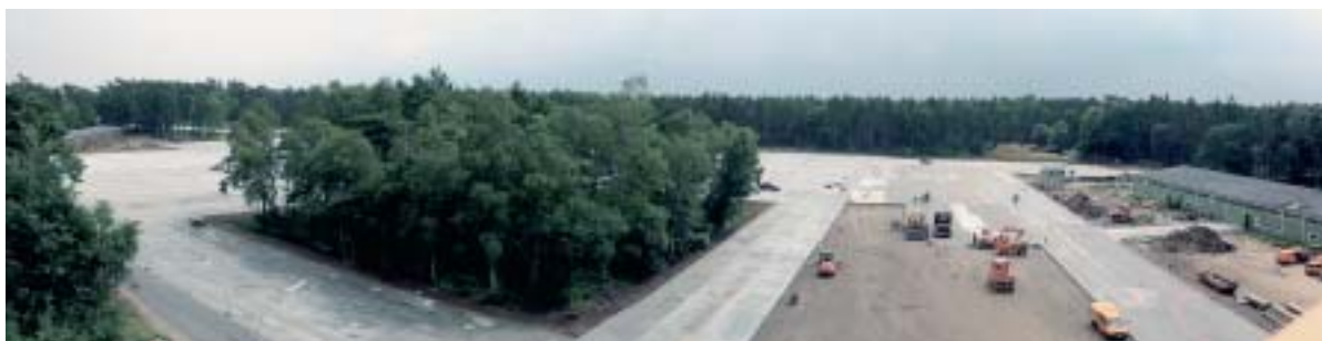
Bild 1: Neubau einer 52.000 m 2 großen Freifläche aus Walzbeton
