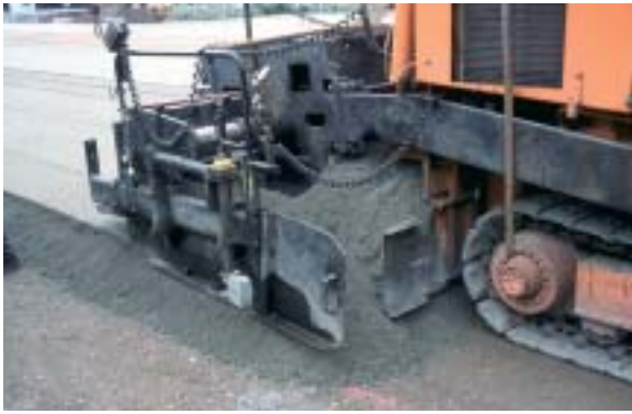
Bild 9: Einbau und Vorverdichtung mit Fertiger
