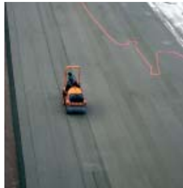
Bild 12: Glätten der Walzspuren mit einer 3,2 t-Glattmantelwalze
