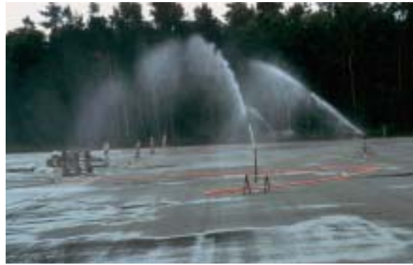
Bild 14: Nachbehandlung der Walzbetonfläche mit Sektorregnern
