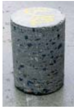
Bild 16: Bohrkern aus der Walzbetondecke
