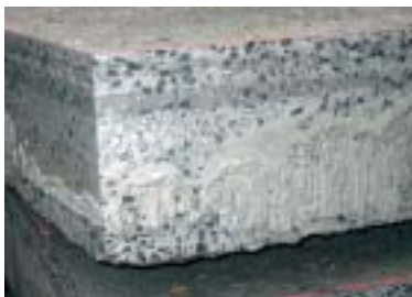
Bild 17: Querschnitt einer aus der Walz- betonstrecke herausgesägten Platte
