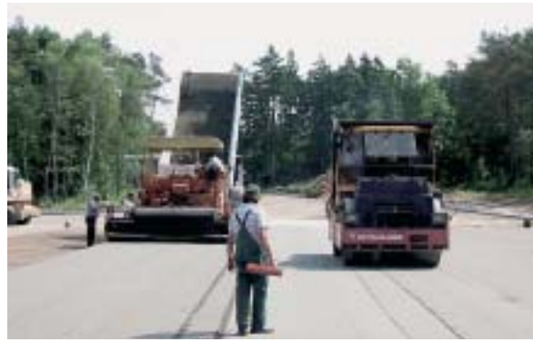
Bild 10: Abwalzen der Fläche mit einer 16 t-Glattmantelwalze
