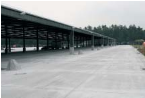
Bild 2: Überbauung der fertigen Walzbetonflächen mit Schutzdächern
