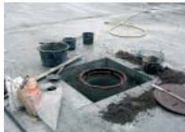
Bild 18: Nachträglicher Einbau der Schachtabdeckung
