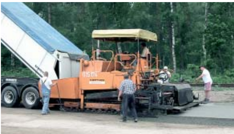
Bild 7: Beschickung des Fertigers mit Sattelaufliegern
