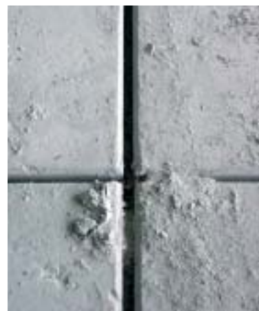
Bild 6: Fugennachschnitt mit angephasteten Kanten
