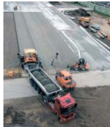
Bild 8: Walzbetoneinbau in Bahnen
