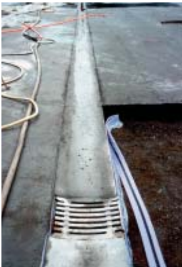
Bild 4: Pendelrinne aus Ort beton
