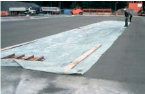
Bild 13: Abdeckung der Walzbetonfläche mit Folie bei Regenrisiko
