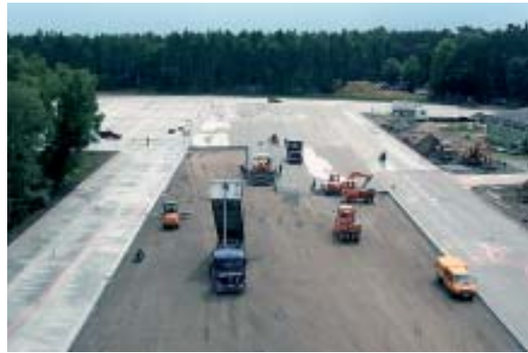
Bild 3: Walzbetoneinbau im Materialdepot Hesedorf
