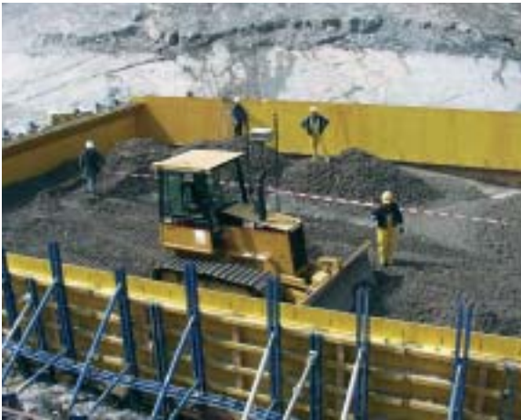
Bild 4: Verteilung des Betons in einem Block mit einem Raupenfahrzeug
