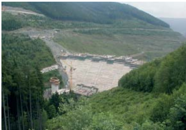
Bild 1: Talsperre Leibis/Lichte im Bauzustand, Juni 2004
