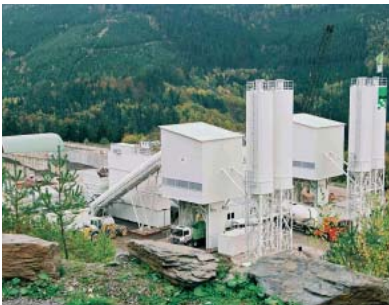
Bild 2: Ansicht der Betonmischanlage auf der Baustelleneinrichtung „Pferdekoppel“
