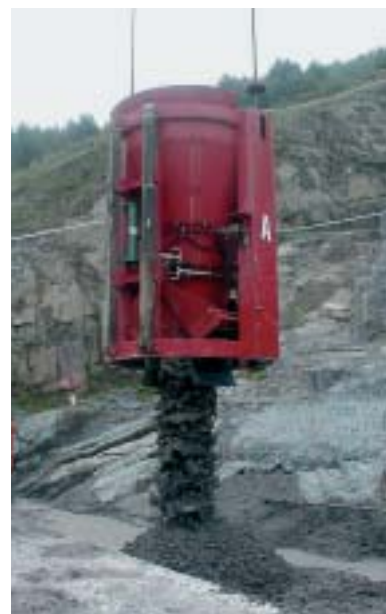
Bild 3: Kabelkrananlage im Einsatz: Betoneinbau mit einem 6 m 3 -Kübel
