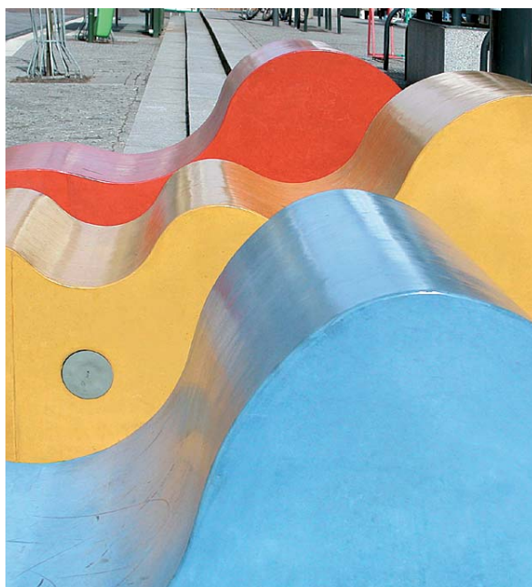
Bild 1: Dessauer Wellen – farbiger Sichtbeton mit glatter und nahezu porenfreier Oberfläche
