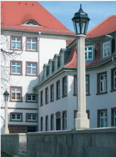
Bild 12: Der originalen Steinmetz- arbeit täuschend ähnlich nachgebildet – Lampenmasten aus Beton in Naumburg
