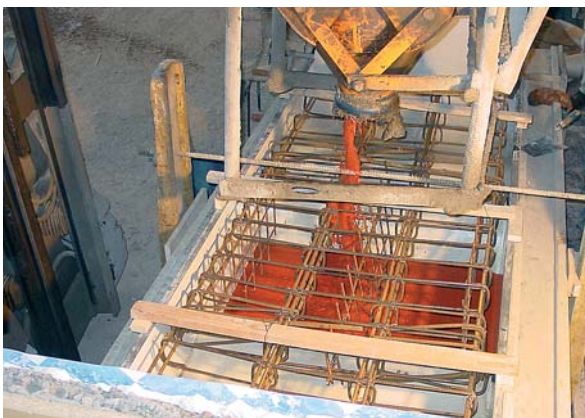
Bild 7: Befüllen der Schalung mit durchgefärbtem SVB-ähnlichem Beton
