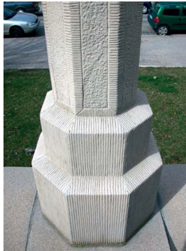
Bild 13: Nachbildung der „Steinmetz- handschrift“ durch Verwendung von Kautschukmatrize und selbstverdich- tendem Beton
