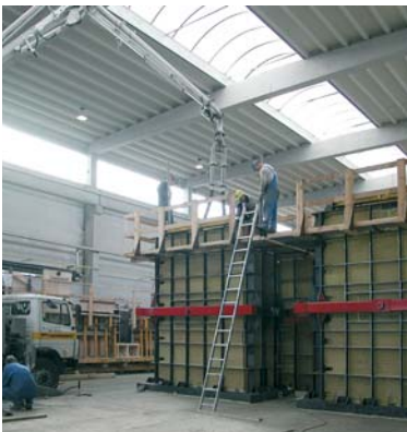
Bild 15: Betonieren der bis zu 5 m hohen Stelen im Fertigteilwerk
