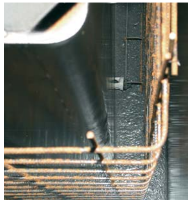
Bild 16: Anthrazitfarbener Beton füllt die etwa 20 cm breite Schalung
