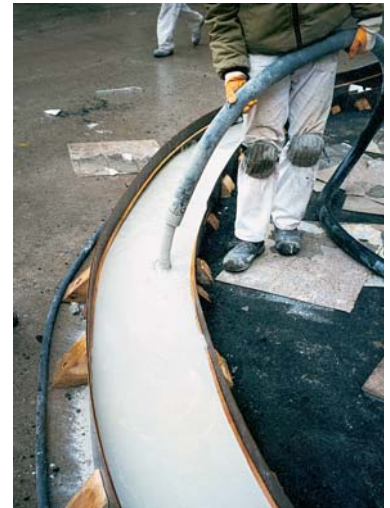
Bild 5: Betonieren des Auffangbeckens eines Springbrunnens in Berlin mit weißem selbstverdichtendem Beton
