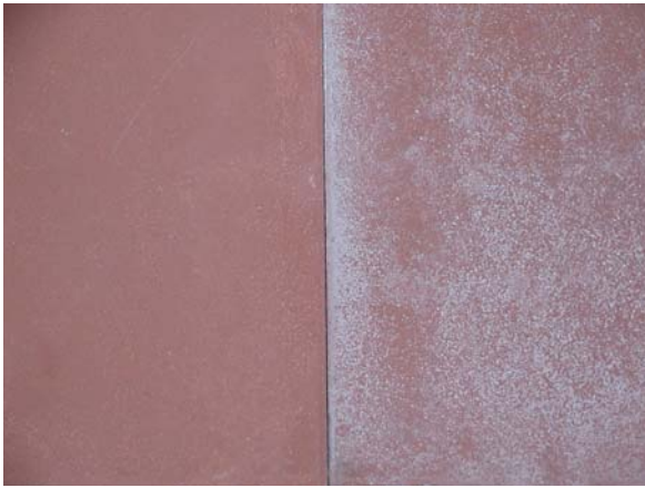
Bild 1: Vergleich des Ausblühverhaltens von Pflastersteinen gleicher Betonzusammensetzung bei gleichen Lagerungsbedingungen: 14 Tage im abgedeckten Stapel bei Zugluft, durchschnittliche Lufttemperatur + 5 °C, durchschnittliche Luftfeuchte 73 %; links Betonwarenzement CEM III/A 52,5 N; rechts CEM I 42,5 R
