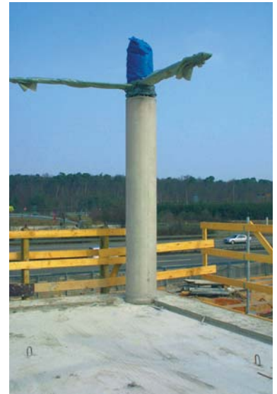
Bild 4: Stütze B 85 aus Veridur® auf Decke aus Normalbeton
