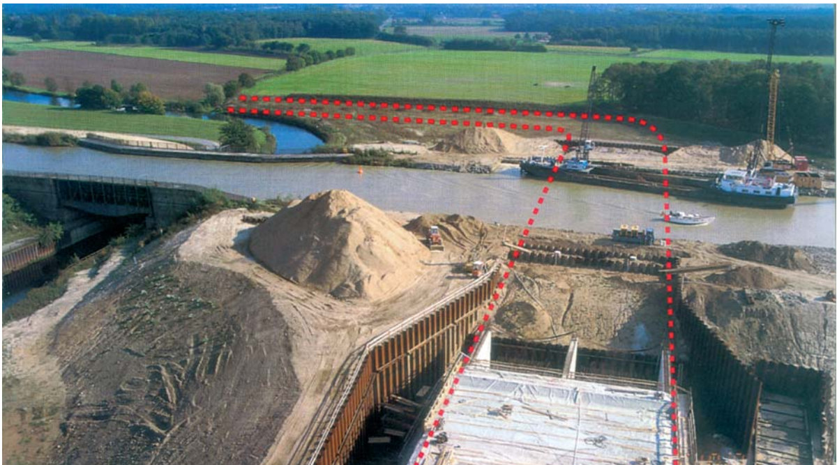
Bild 2: Unterfahrung des Dortmund-Ems-Kanals mit dem Stever-Durchlass (Philipp Holzmann AG)
