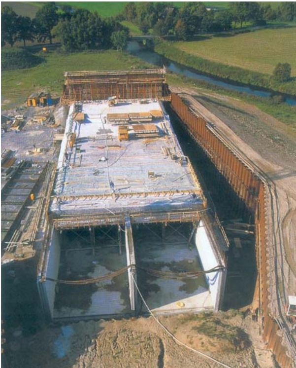
Bild 3: Herstellung des Mittelteils Ste- ver-Durchlass im Baudock (Philipp Holz- mann AG)
