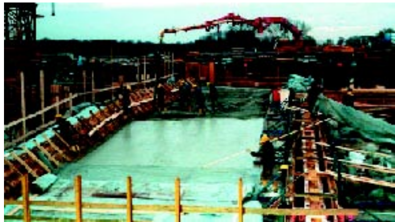
Bild 16: Durchführung der Nachbehandlungsmaßnahmen: Auflegen von Wärmedämmmatten nach der Oberflächenbearbeitung
