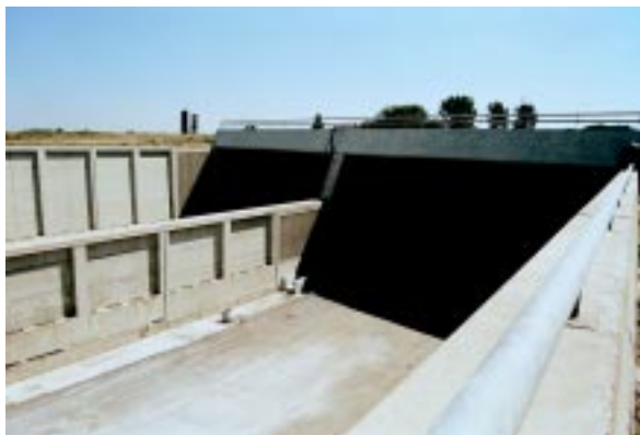
Bild 10: Westportal des Tunnels Rheinschlinge
