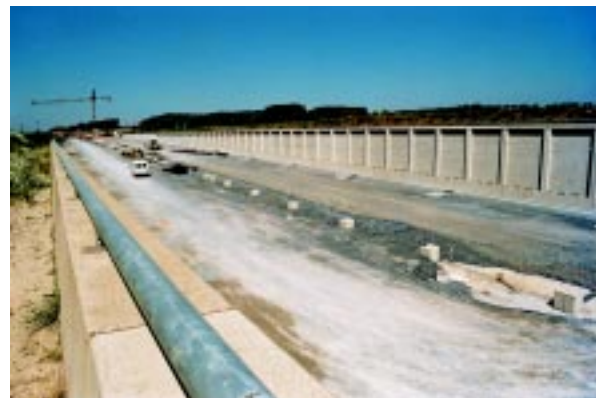
Bild 11: Westliche Trogstrecke vor dem Tunnel Rheinschlinge
