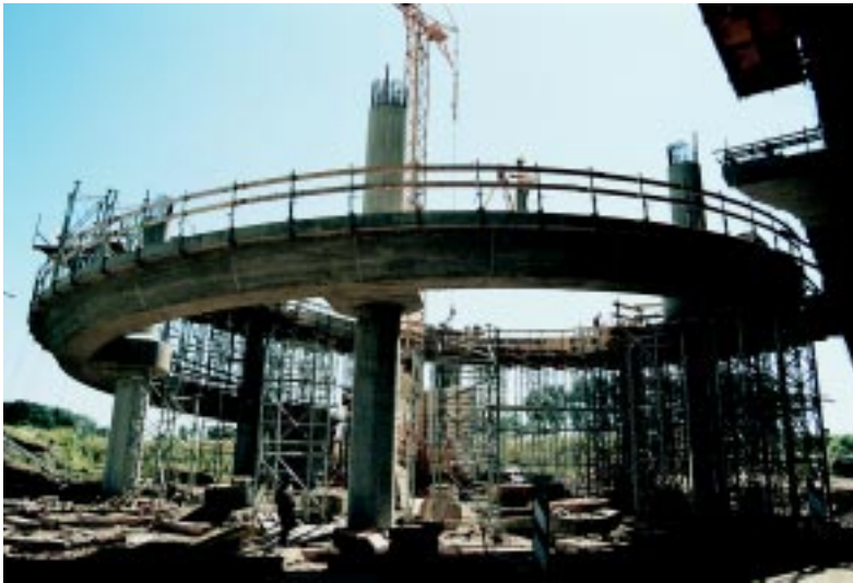
Bild 19: Erstellung der Pfeiler und des Plattenbalkens für die etwa 7° geneigte Gehwegspindel
