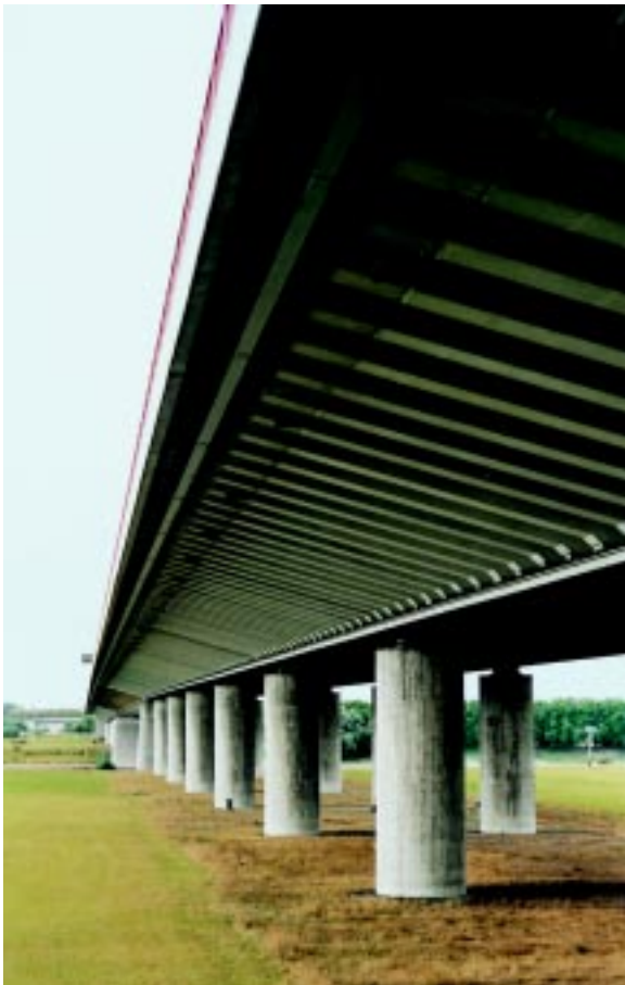
Bild 20: Druckstreben der Vorlandbrücke im Zuge der BAB A 42; Rheinquerung Duisburg-Baerl
