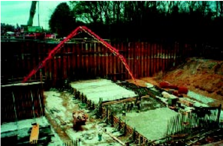
Bild 14: Spundwandverbau des „Trockendocks“ für den Bau des nächsten Tunnelabschnitts
