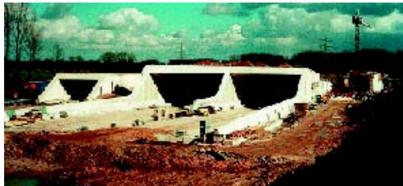
Bild 12: Westliches Portal des Haupttunnels Strümp mit der Einhausung Nord für die Einfahrt auf die A 44 in Richtung Mönchengladbach nach Fertigstellung
