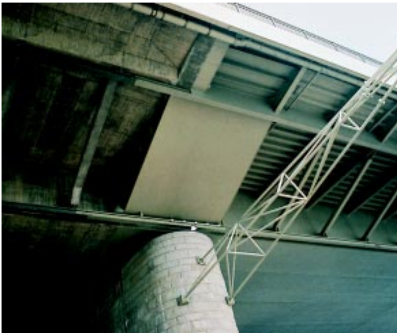
Bild 22: Den Abmessungen der Stahl-Druckstützen angepasste Druckstreben aus Hochleistungsbeton B 75
