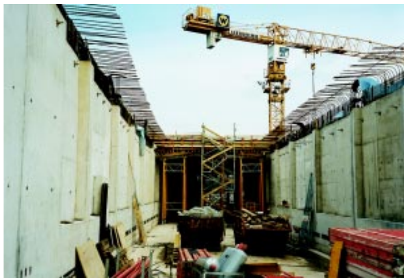
Bild 13: Einhausung Nord im Bereich der Auffahrt im Bau
