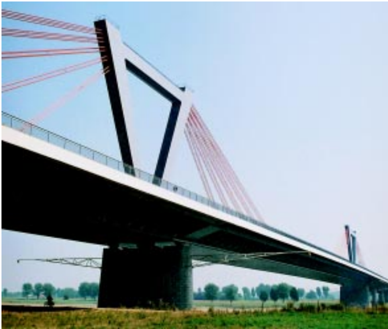
Bild 9: Neugestaltete Brückenpylone der Flughafenbrücke
