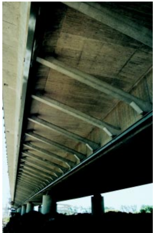
Bild 21: Druckstreben der Vorlandbrücke im Zuge der BAB A 44; Rheinquerung Ilverich
