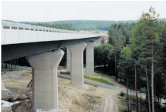
Bild 2: Brückenpfeiler in Ost-West-Ansicht
