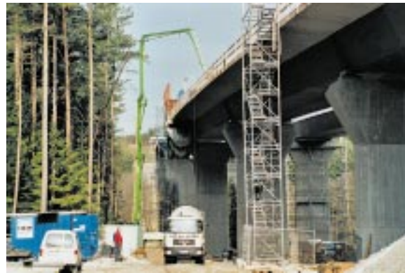
Bild 3: Einbau des Betons für den Überbau
