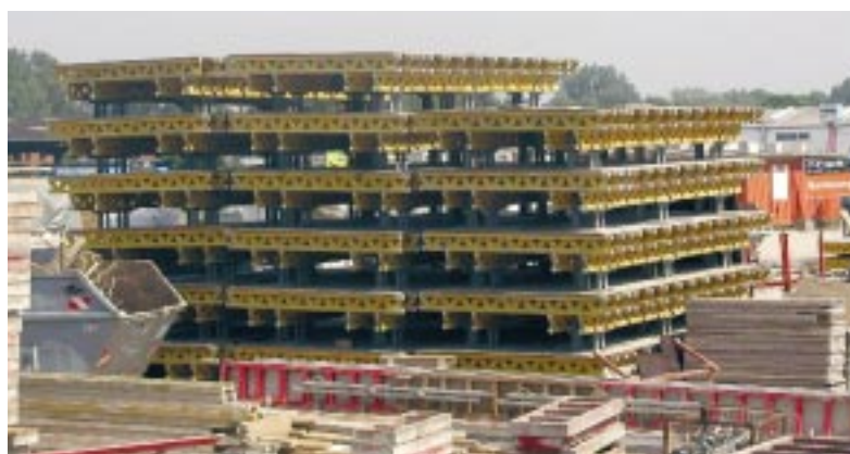
Bild 12: Lagerung der Schaltafeln im Freien auf der Baustelle
