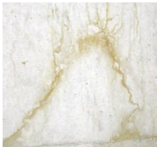
Bild 17: Organische Abbauprodukte aus dem Phenolharzfilm färben die Betonoberfläche braun.
