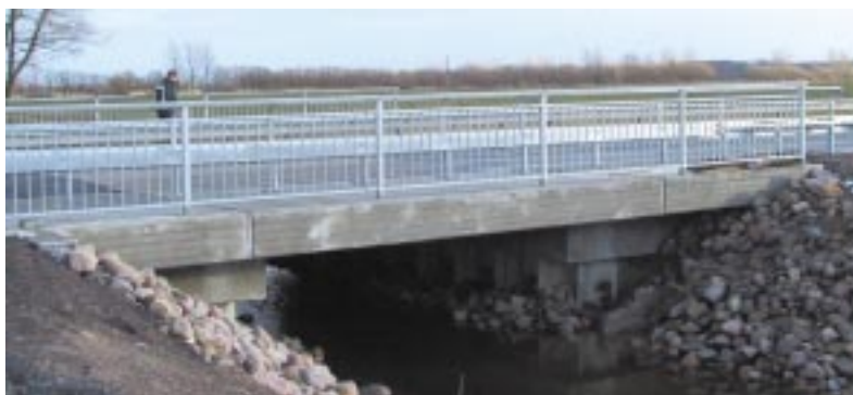
Bild 1: Brücke bei Rethwisch („Brücke R“) – Ansicht Westseite
