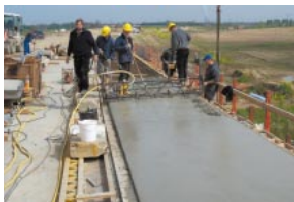
Bild 7: „Brücke G“ (Außenkappe Brückenteil Ost) – Verdichten und Abziehen des Kappenbetons mit Rüttelbohle
