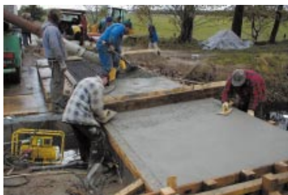
Bild 6: „Brücke R“ (östliche Brückenkappe) – Einbringen, Verdichten, Abziehen und Glätten des Kappenbetons
