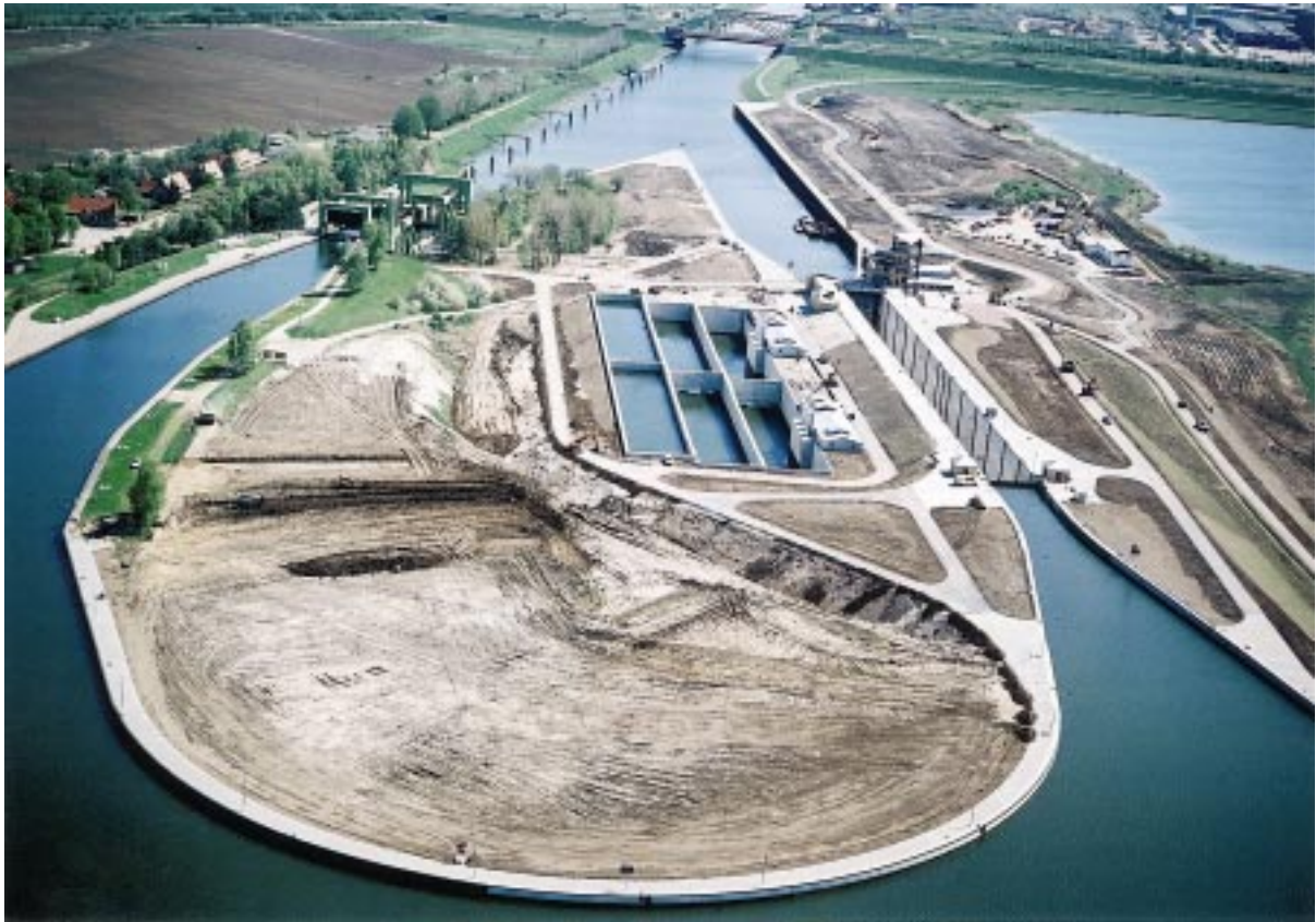
Bild 2: Blick vom Mittellandkanal in den Rothenseer Verbindungskanal; links das Schiffshebewerk (Baujahr 1938), rechts die 2001 freigegebene Sparschleuse Rothensee gegen Ende der Bauzeit
