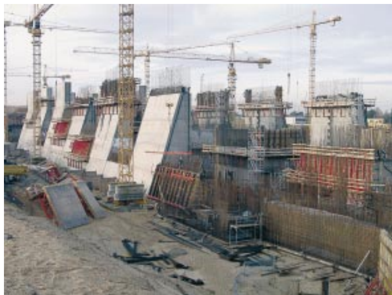
Bild 22: Intensiver Schalungseinsatz unter Anwendung von Kletterschalung mit 6 Takten im Bereich der Kammer
