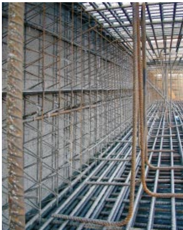
Bild 17: Senkrechte mit Streckmetall abgestellte Arbeitsfuge eines 2,50 m hohen Betonierabschnitts der Sohle
