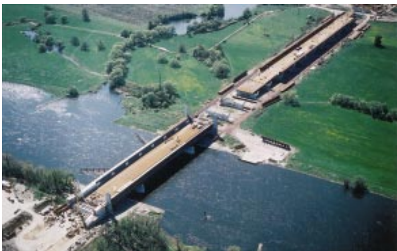
Bild 3: Kanalbrücke, bestehend aus der Vorlandbrücke (690 m) und der Strombrücke (228 m)
