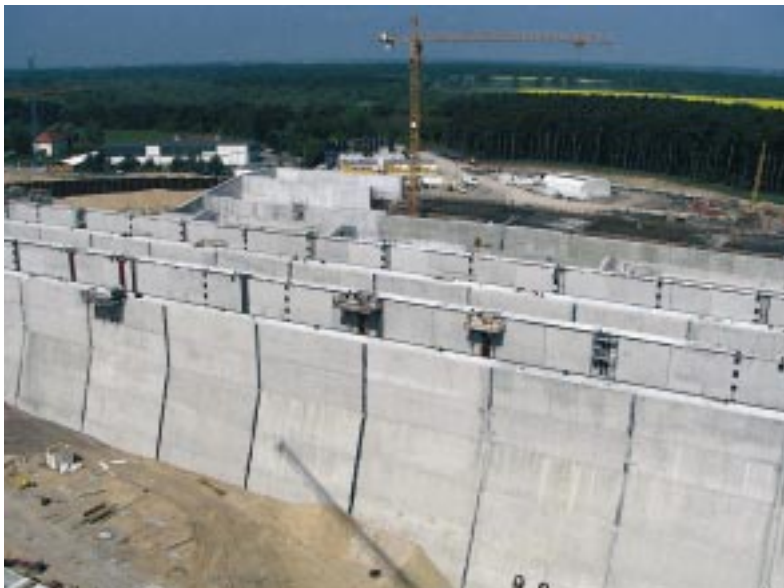
Bild 6: Schleusenkammern und Mittelmole mit Dehnfugenabständen von 13,25 m und einer Fugenbreite von 3 cm.
