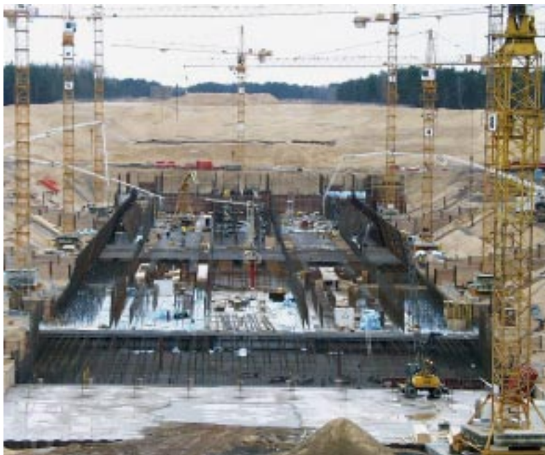
Bild 9: Dehnfugenlose Gründungssohle – Länge: 246,5 m; Breite: 54,1 m bis 65,0 m; Dicke: 5,5 m
