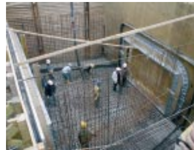
Bild 10: Sparbecken-Zulaufkanal; Block 1 im Bauzustand mit beidseits angeordneten auswechselbaren Omega-Dehnfugenbändern
