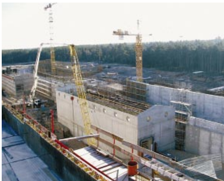
Bild 18: Betoneinbau im Bereich der Sparbeckenanlage; im Vordergrund die Maschinenhäuser, in denen der Zulauf aus den Sparbecken über Gleitschütze gesteuert wird
