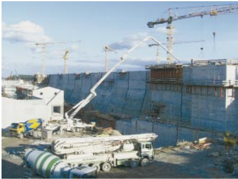
Bild 21: Betoneinbau mit Autobetonpumpe 52 m und 10 m Traverse im Bereich des Oberhauts
