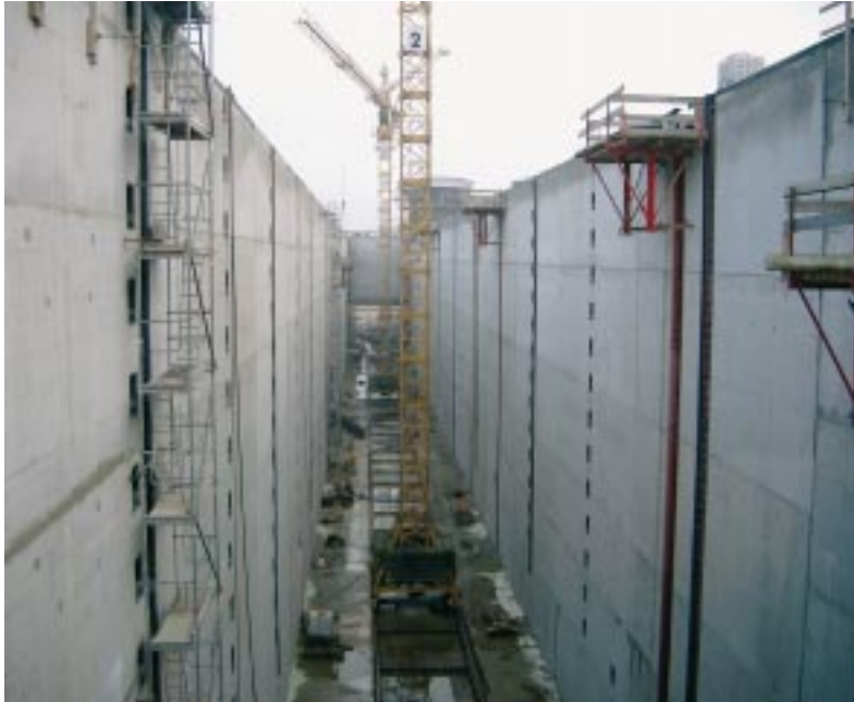
Bild 5: Blick in die Nordkammer, Kammerwandhöhe 24,45 m
