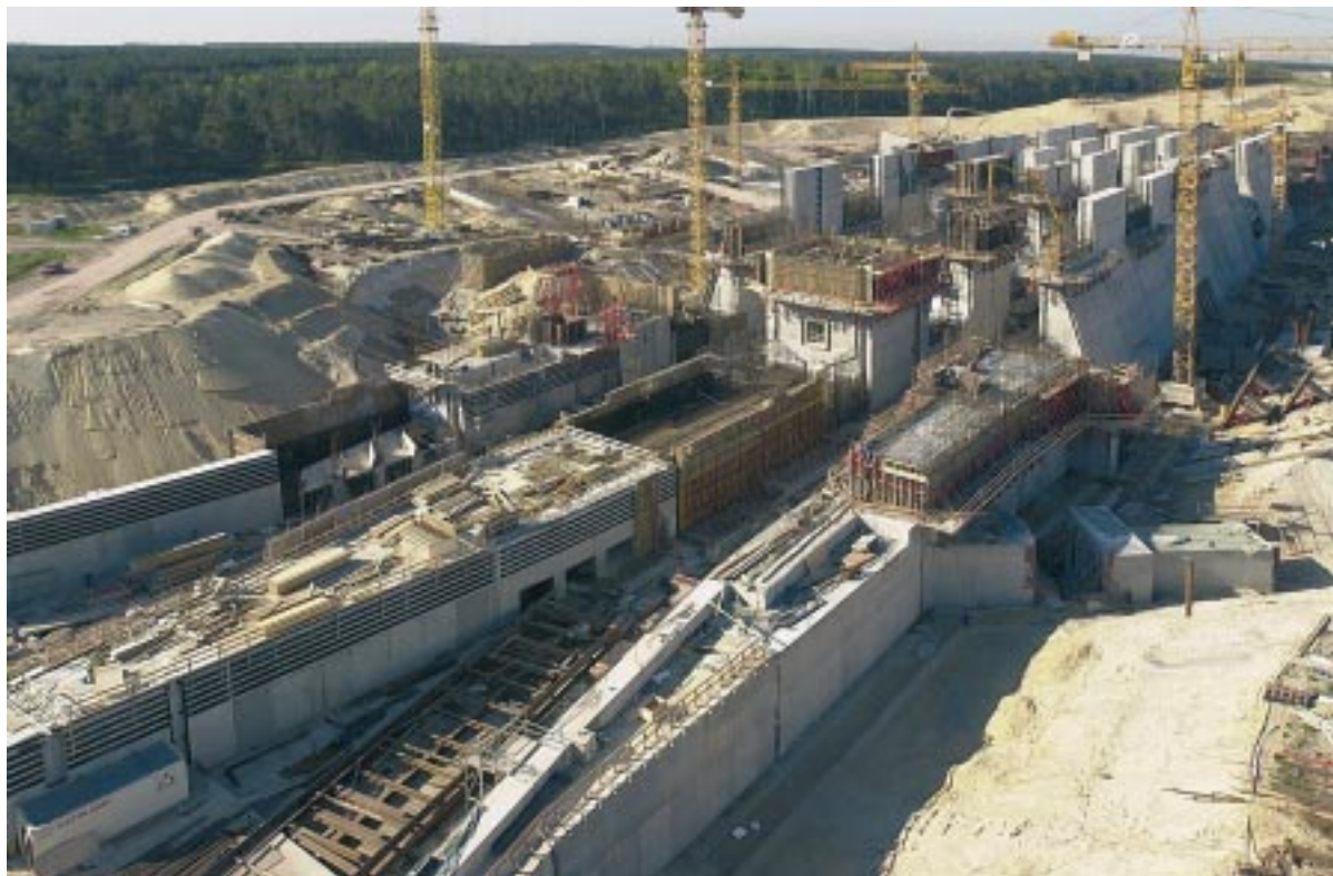
Bild 4b: Schleuse Hohenwarthe - Bauzustand
