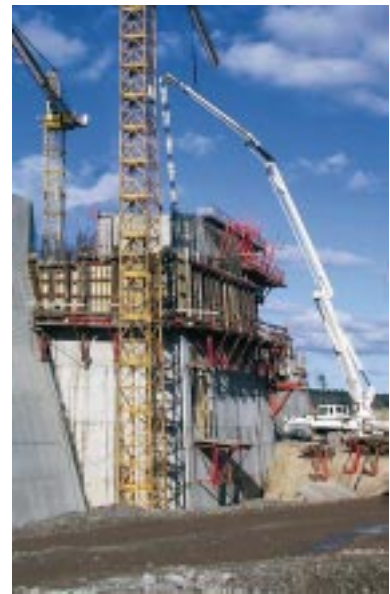
Bild 20: Betoneinbau am Unterhaupt der Schleuse mit Autobetonpumpe 52 m
