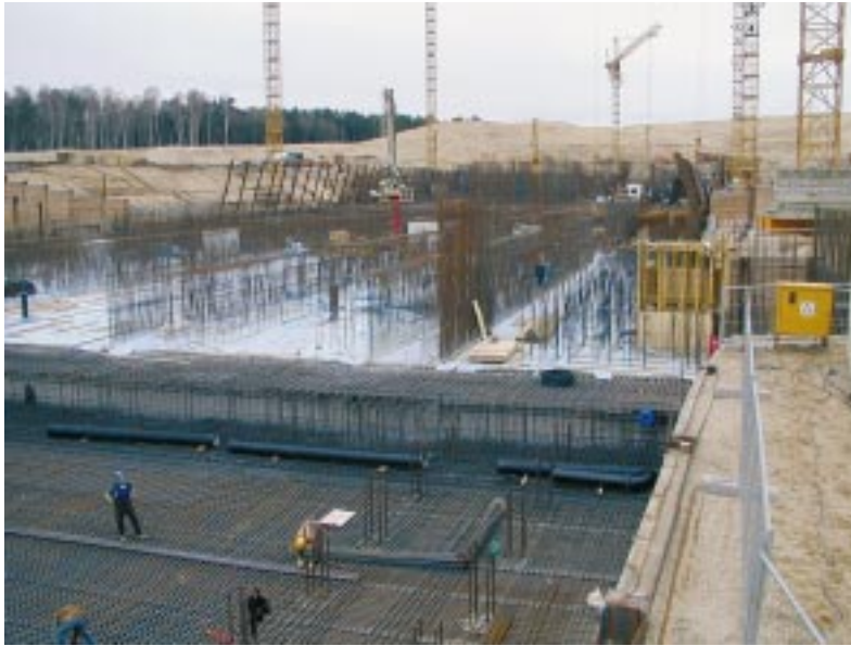
Bild 23: Schleusensohle – Nachbehandlung durch Abdecken mit Wärmedämmmatten
