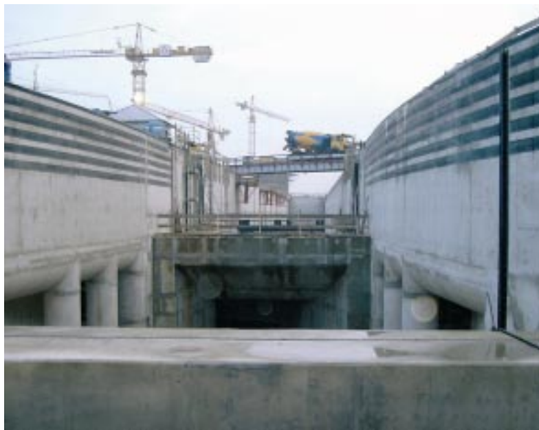
Bild 11: Einlaufbauwerk mit beidseitig angeordneten Längskanälen. Im Hintergrund die Behelfsbrücke über die Südkammer zur Ausführung von Erd- und Betonarbeiten auf der Mittelmole
