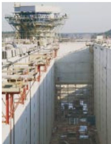
Bild 14: Schleusenbetriebsgebäude am Unterhaupt; rechts im Bild Blick auf die Tormaske der Südkammer
