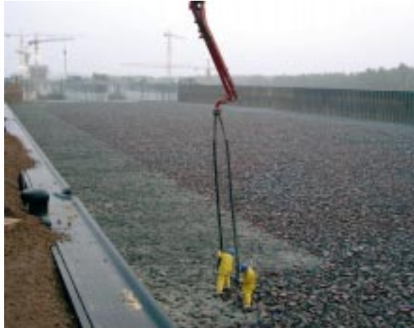
Bild 16: Oberer Vorhafen; Einbringen von Verklammerungs-beton im Bereich der Liegeflächen auf einer Breite von 12 m (Teilverguss: 90 l/m², Vollverguss: 180 l/m²)
